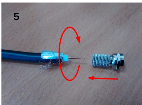
Заделка кабеля
